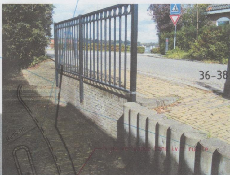
IJsselsteentjes als voetpad langs het Rijnlandshuis. Klinkers in waalformaat hergebruiken in de nieuw te maken oprit.
