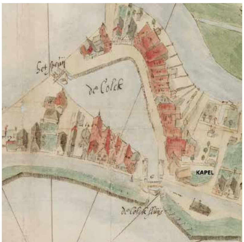
De locatie van de kapel van omstreeks 1328, rechts op de hoek bij “de Colck Sluis”
