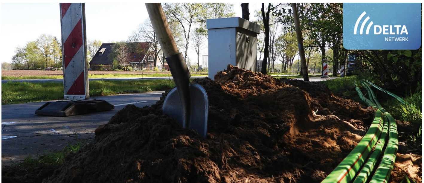
Aanleg glasvezelnetwerk DELTA Netwerk start binnenkort
