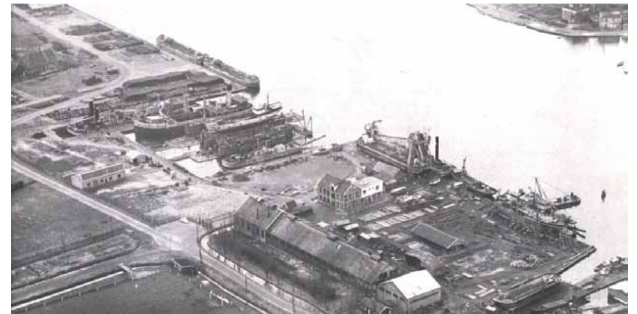
Overzichtsfoto na het realiseren van de omvangrijke uitbreiding.
