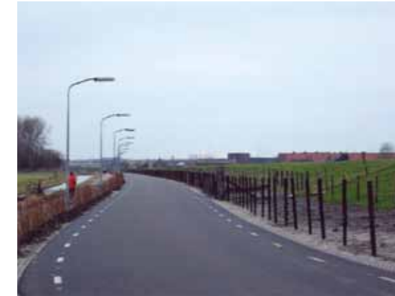
Zo ziet de vernieuwde weg er uit langs de Slaperdijk.
