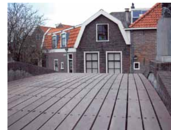
De nieuwe vloerdelen van de Woerdersluis.
