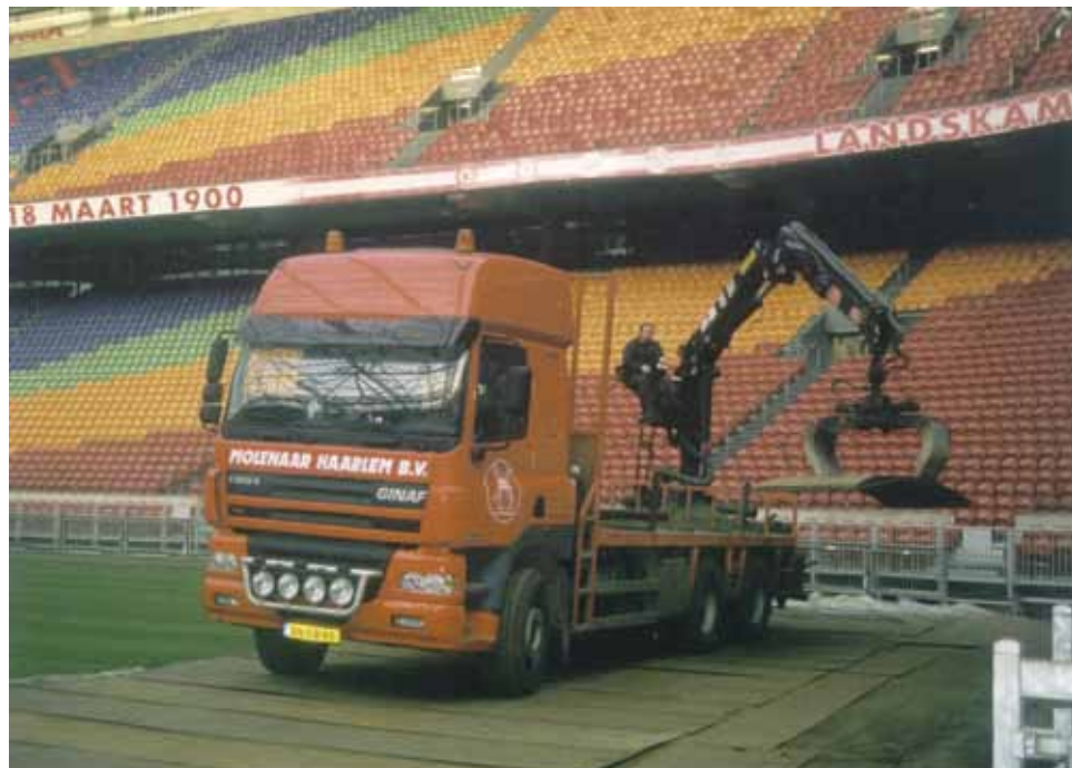
Rijplaten leggen in de Amsterdam Arena
