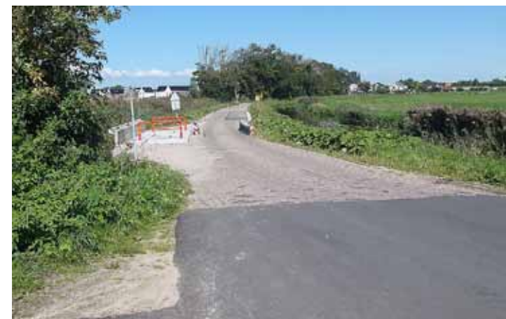
Overgang Lageweg naar Lagedijk (Lage Dreef); links van de weg-versmalling; de nieuwe omleiding voor hulpverleningsdiensten.
